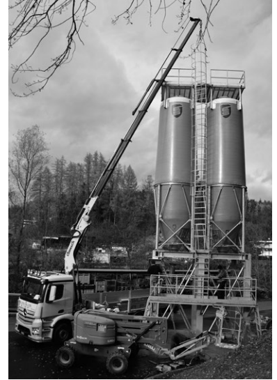
Montage Streusalzsilos im November 2019
